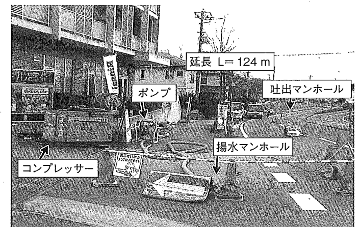
写真-5 須賀川市での災害復旧工事での水替工のようす
