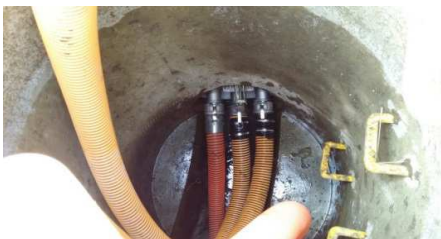
・ ポンプ3台での施工状況
