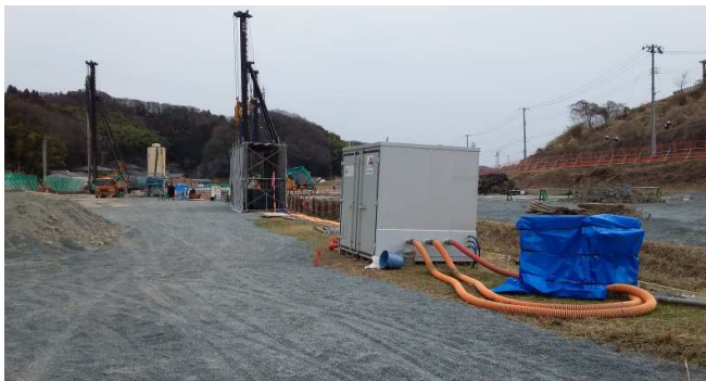
・ 施工状況と防音対策状況
