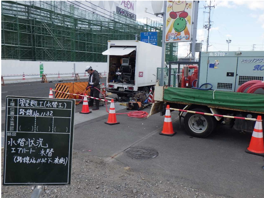
エアハート工法による水替状況
