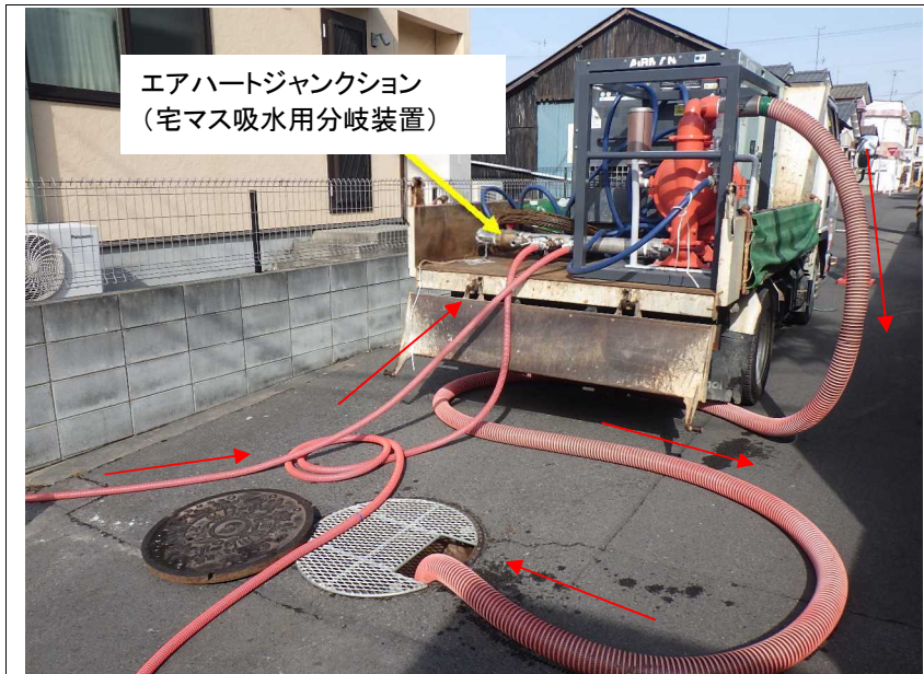
エアハート工法による水替状況
