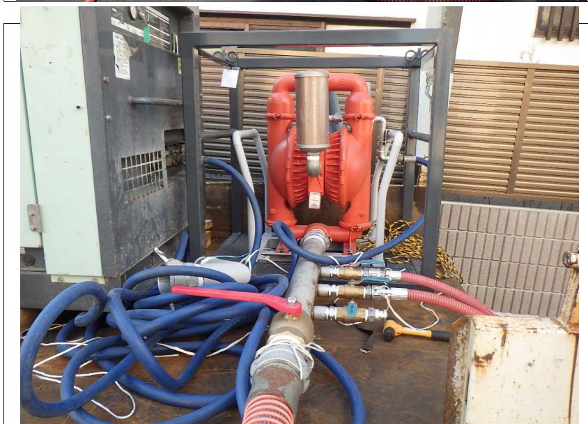
エアハート工法による水替状況
